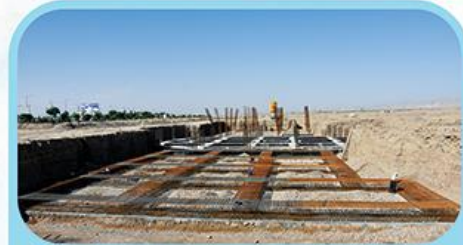
آرما توربندی فونداسیون پارت شرق
