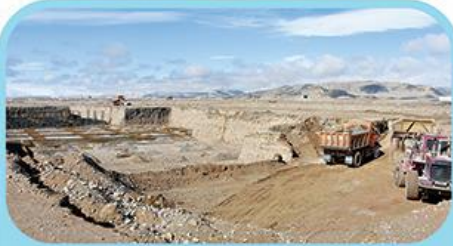
آغاز عملیات خاکبرداری بونگرهای پرتو درمانی
