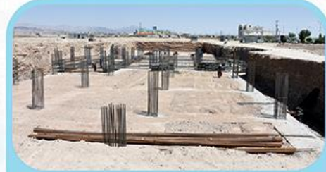
اجرای ستون های طبقه زیر زمین پارت غرب
