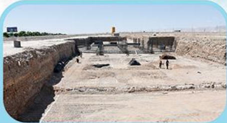
پیااده سازی ، تسطیح و رگلاژ فونداسیون پارت شرق
