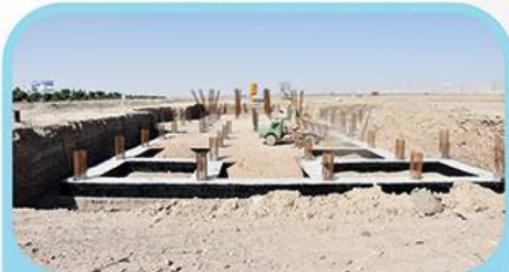
پرکردن چشمه های فونداسیون و آماده سازی جهت اسکلت طبقه اول
