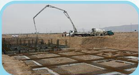
آرماتور بندی و بتن ریزی فونداسیون پارت غرب
