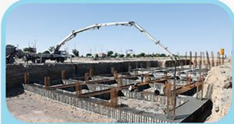
بتن ریزی فونداسیون پارت شرق
