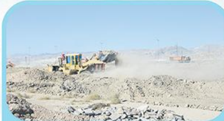
عملیات خاکبرداری با ماشین آلات
