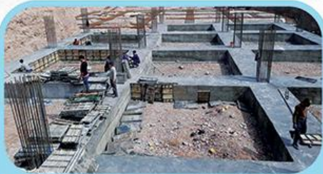
آغاز آرماتور بندی فونداسیون پارت مرکزی
