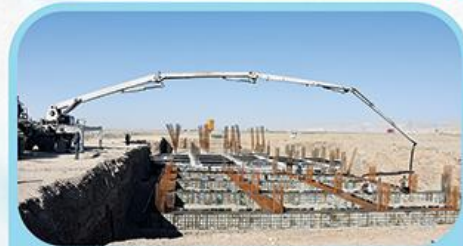
بتن ریزی فونداسیون پارت شرق
