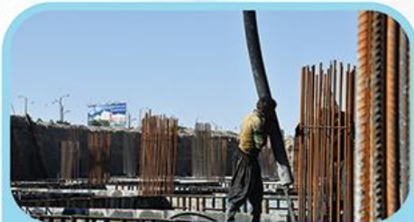
بتن ریزی فونداسیون پارت شرق
