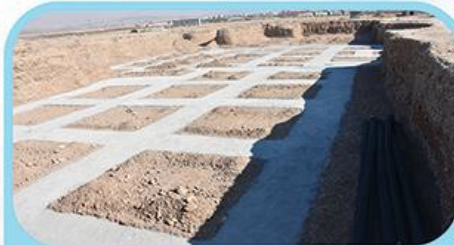
اجرای بتن مگر فونداسیون های پارت غرب و مرکزی
