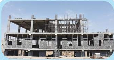
اجرای وال پست و بلوک چینی طبقه همکف ضلع جنوبی ، آرماتوربندی سقف طبقه اول زون شرقی
