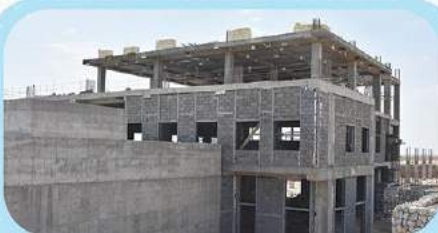
بلوک چینی ضلع شرقی دیوار پیرامونی طبقه زیرزمین و همکف زون شرقی - اجرای دیوار حائل ، محل اتصال زون شرقی به زون مرکزی
