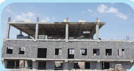
اتمام بلوک چینی دیوار پیرامونی طبقه زیر زمین و طبقه همکف جمع آوری داربست زیر سقف طبقه اول زون شرقی
