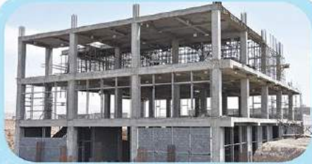
بلوک چینی دیوار پیرامونی طبقه زیر زمین - اجرای وال پست طبقه همکف - نصب داربست زیر سقف طبقه اول زون شرقی
