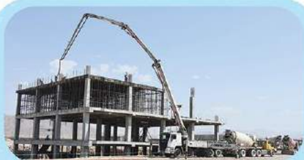
بتن ریزی سقف طبقه اول زون شرقی
