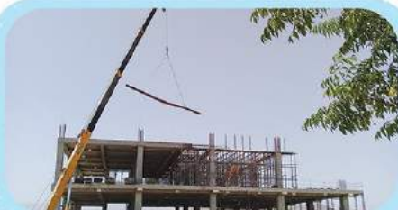
انتقال میلگردها جهت آرماتوربندی سقف طبقه اول
