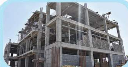
اجرای وال پست و بلوک چینی طبقه زیر زمین و طبقه همکف ضلع غربی و شمالی - شروع آرماتوربندی سقف طبقه اول زون شرقی
