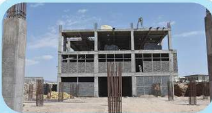
بلوک چینی طبقه زیرزمین و طبقه همکف انتقال بلوک های سیمانی لیکا به طبقه اول
