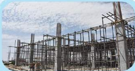
اجرای داربست زیر سقف طبقه اول
