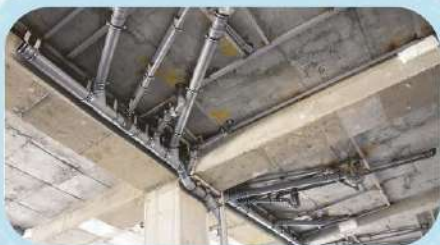
اجرای لوله‌های فاضلاب و آب باران زیر سقف
