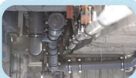
اجرای لوله های فاضلاب و آب باران در زیر سقف طبقات
