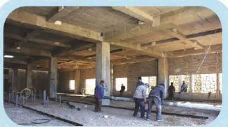
قالب بندی طبقه زیرزمین قبل از بتن ریزی
