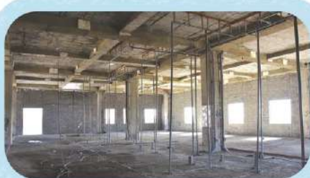
اجرای لوله های ونت در طبقات
