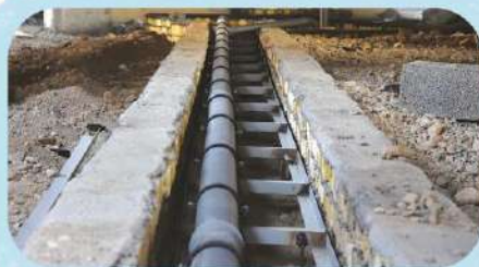
نصب لوله‌های فاضلاب پوشفیت داخل ترنج‌ها به همراه ساشی‌کشی
