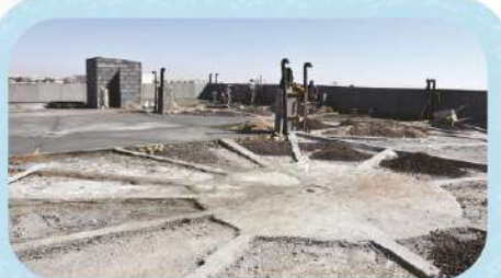
کروم بندی، پوکه ریزی و سیمان کاری بام زون شرقی
