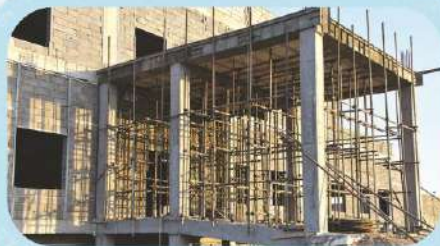
اجرای داربست زیر سقف دوم سازه سردر ورودی زون شرقی
