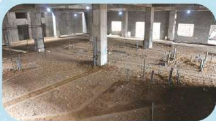
کف‌سازی طبقه زیرزمین
