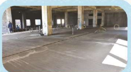
اتمام بتن ریزی کف زیر زمین مرحله اول
