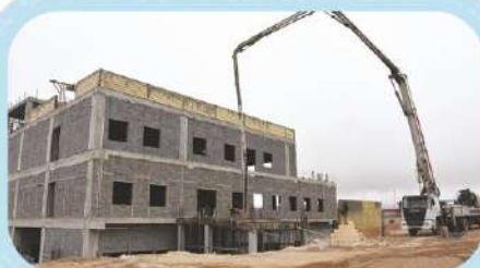
بتن‌ریزی سقف اول سردر ورودی زون شرقی
