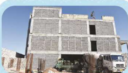
بتن ریزی کف زیر زمین مرحله اول
