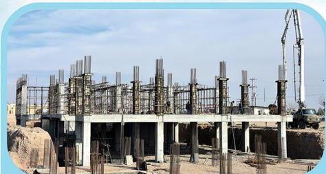
بتن ریزی ستون های طبقه اول زون شرقی
