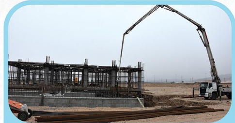
تکمیل بتن ریزی دیواره های سازه بونکرهای رادیوتراپی
