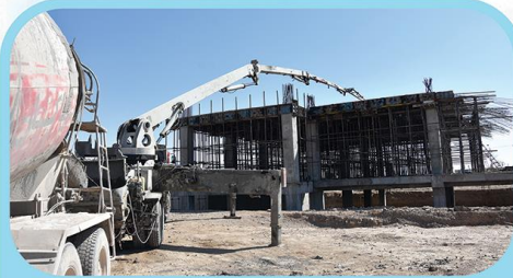
بتن ریزی سقف طبقه اول (آزمایشگاه و کلینیک تخصصی)
