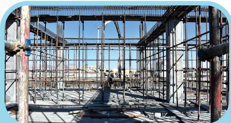
اجرای داربست زیرسقف طبقه اول زون شرقی
