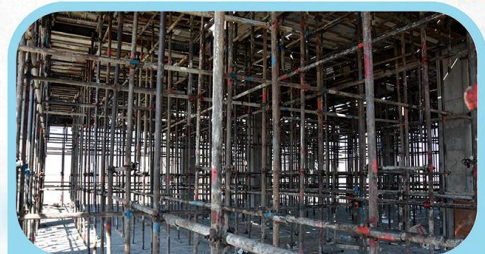
قالب بندی زیرسقف طبقه همکف زون شرقی
