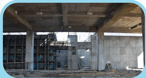
قالب بندی دیوار ضلع غربی سازه ی بونکرهای رادیوترایی
