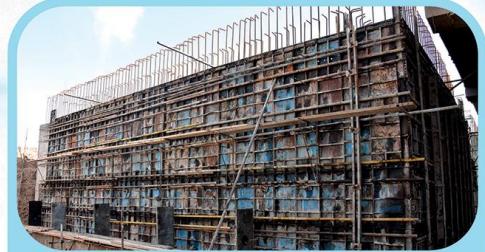
قالب بندی دیواره های سازه بونکرهای رادیوتراپی
