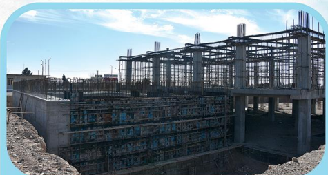
قالب بندی دیوار ضلع شمالی سازه ی بونکرهای رادیوترایی
