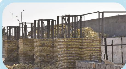
شاسی کشی داخل داکتهای تاسیسات بونکر
