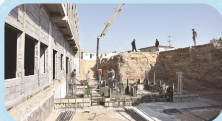
عملیات بتن ریزی فونداسیون سازه سر درب
