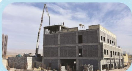
بتن ریزی سقف خرپشته زون شرقی
