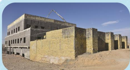
دیوار چینی جانپناه بونکر ، ضلع جنوبی
