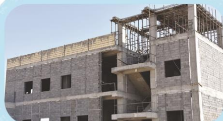
آرماتوربندی تیرهای سقف خرپشته
