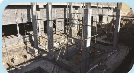
باز نمودن قالب ستون های اول سر درب و اجرای داربست زیر سقف
