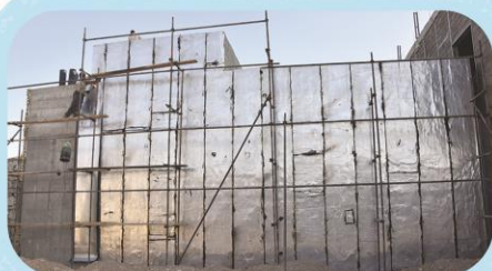
۵ تکمیل اجرای نصب ایزوگام دیوار شمالی بونکر
