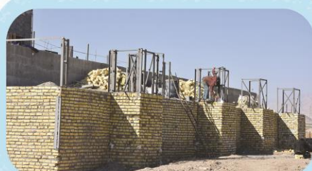
کلاف بندی و شاسی کشی داکتهای تاسیسات بونکر
