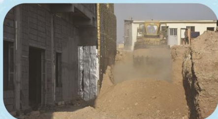
۴ احداث رمپ دسترسی زون شرقی
