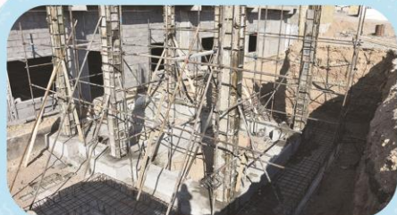
قالب بندی ستون های سر درب و اجرای داربست زیر سقف
