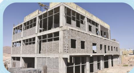
۱ اجرای دیوارهای پیرامونی زون شرقی
