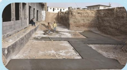
۴ اجرای بتن مگر فونداسیون دیوار حائل جنوبی و سردرب
