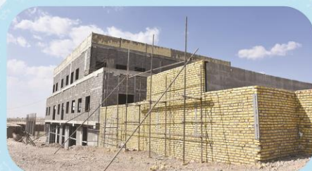
۲ دیوار چینی آجری ضلع جنوبی بونکر
