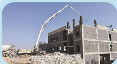
۷ بتن ریزی ستون های خرپشته
