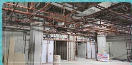
اجرای شاسی‌کشی سقف کاذب و ورودی اتاق رادیوترایی
