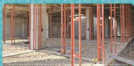
ساخت و نصب وال‌پست و دیوارهای موتورخانه و اجرای بلوکاز کف
