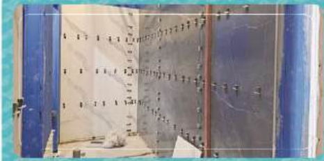
شروع کاشی‌کاری دیوارهای بخش رادیوتراپی
