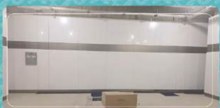
تکمیل نازک‌کاری فضای بونکر با MDF
