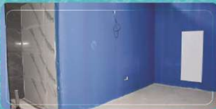
اجرای عایق آبی دیوارهای کتاف و شروع کاشی کاری فضاهای تر
