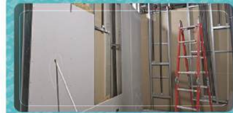
اجرای تأسیسات مکانیکی و الکتریکی بین دیوارهای کناف در اتاق‌ها
