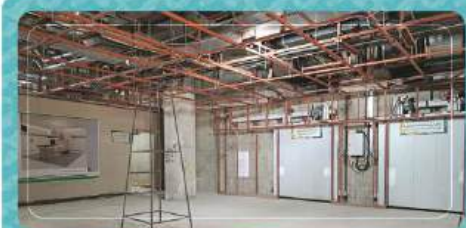
شاسی‌کشی سقف کاذب بخش انتظار رادیوتراپی
