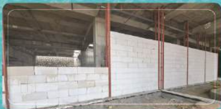
اجرای دیوارچینی موتورخانه زون مرکزی با بلوک هبلکس
