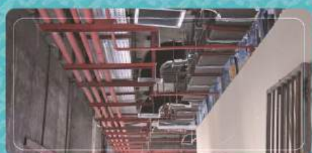
اجرای تأسیسات مکانیکی و الکتریکی زیر سقف راهرو تردد بیماران
