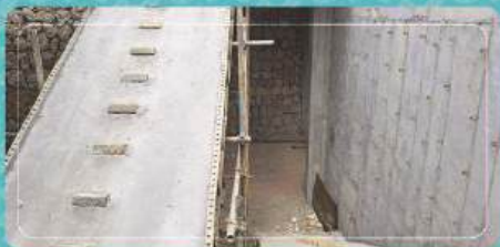
اتمام بتن ریزی شمشیری های راه پله زیرزمین زون مرکزی
