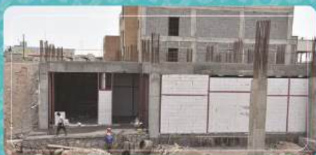
اجرای دیوار موتورخانه زون مرکزی با بلوک هبلکس و اجرای فتداسیون ورودی موتورخانه
