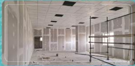
اجرای سقف کاذب سالن جلسات طبقه همکف و بتونه کاری دیوارها
