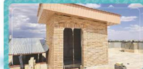
تکمیل نمای اتاقک تابلو برق زون شرقی
