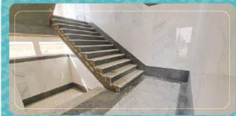
اجرای سنگ دیوارهای راه‌پله زون شرقی
