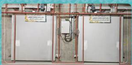
تکمیل شاسی‌کشی درهای اتاق رادیوترایی
