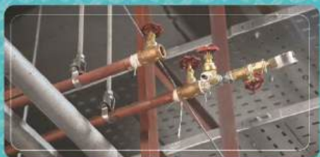
نصب شیرهای آبرسانی
