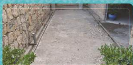
تسطیح و رگلاژ خاک گودال باغچه جنوبی زون شرقی قبل از بتن‌ریزی
