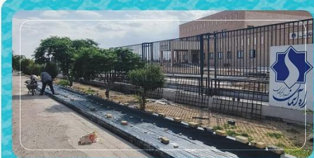
اجرای دال‌های بتنی برای تعبیه روی کانال جمع‌آوری آب‌های سطحی محوطه
