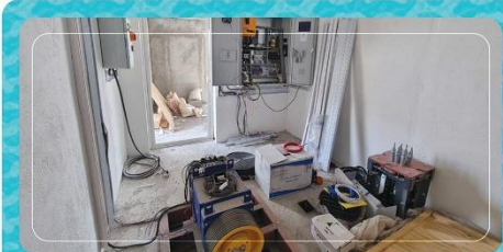
نصب تابلو برق و موتور آسانسور زون شرقی
