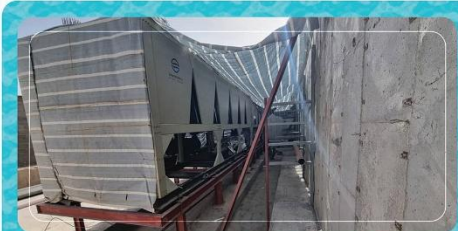
اجرای عملیات شاسی‌کشی لوله‌های آب چیلر مرکزی از گودال باغچه شمالی زون غربی به موتورخانه
