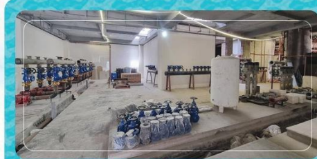
ساخت کلکتورها و نصب پمپ‌های موتورخانه مرکزی
