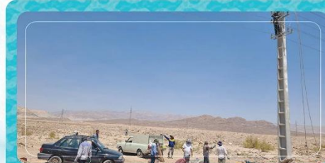
عملیات اجرای کاشت تیرها و عبور خط هوایی برق از سمت جاده کمربندی به سایت پروژه
