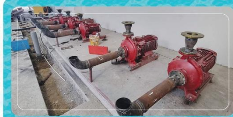
نصب پمپ‌های آبرسانی و اجرای تأسیسات مکانیکی موتورخانه
