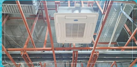
شاسی‌کشی و نصب فن‌کوئل‌های سقفی بخش رادیوتراپی
