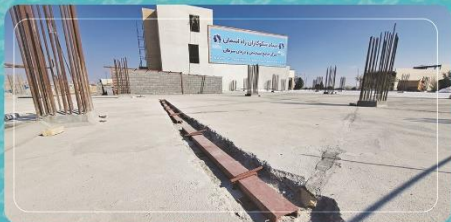
اجرای شاسی‌کشی اتاق‌های ترانس و تابلو برق موتورخانه از روی سقف زون مرکزی
