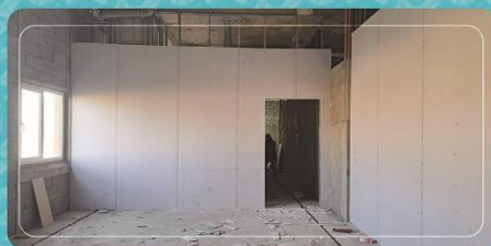
اجرای کلینیک‌های طبقه همکف زون شرقی با سازه کناف
