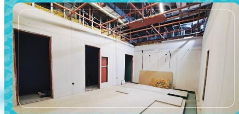
تکمیل عملیات اجرایی در اتاق سی‌تی‌سی سیمولاتور به همراه اتاق‌های مرتبط
