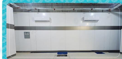
نصب اسپلته‌ها و تکمیل نازک‌کاری دیوارهای بونکر اول
