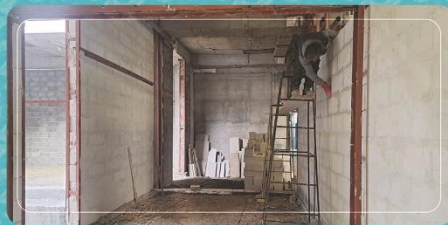
اجرای پست برق موتورخانه زون مرکزی با بلوک هبلکس
