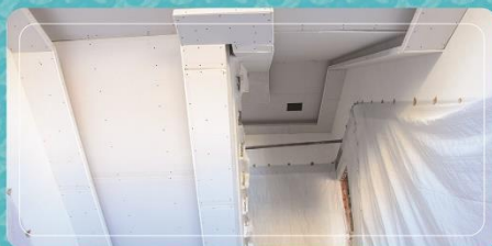
تکمیل اجرای کناف سقف پله زون شرقی
