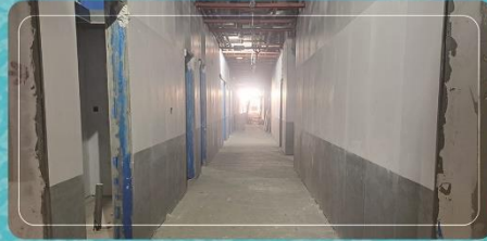
تکمیل اجرای سرامیک دیواره راهرو بخش رادیوتراپی
