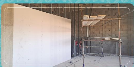
اجرای تیغه‌چینی با سازه کلاف (ساخت) کلینیک‌های طبقه همکف زون شرقی
