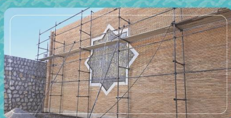
اجرای نمای دیوار شمالی بونکر در گودال باغچه شمالی زون شرقی
