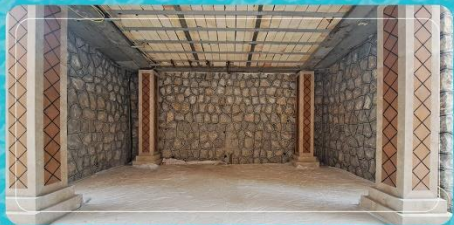
تکمیل نمای ستون‌های سردر ورودی زیرزمین
