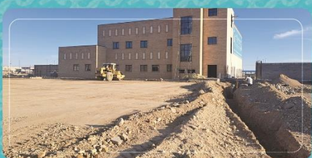
خاک‌ریزی و تسطیح محوطه شمالی زون شرقی و حفاری برای لوله گاز
