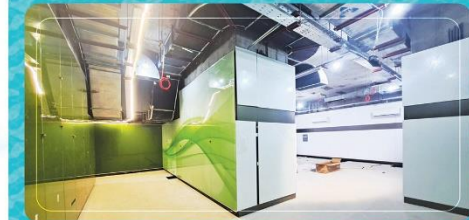
اجرای نازک‌کاری دیوارهای بونکر اول با MDF و شیشه
