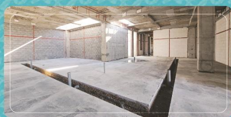
اجرای تأسیسات فاضلابی و بتن‌ریزی کف موتورخانه اصلی (مکانیک)
