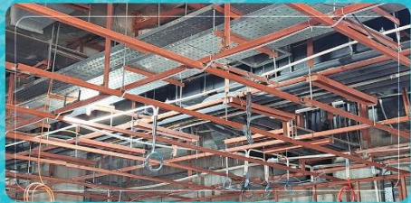
ادامه اجرای تأسیسات الکتریکی شامل کابل‌کشی‌های شبکه، صوت و ...
