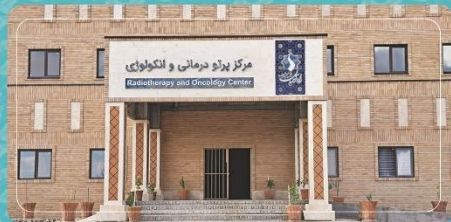
نصب تابلو مرکز پرتو درمانی و آنکولوژی
