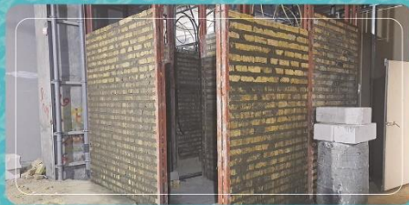
ساخت سرویس‌های بهداشتی طبقه همکف زون شرقی کلینیک‌ها
