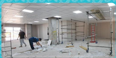
اجرای راهرو ورودی و سقف طبقه همکف زون شرقی
