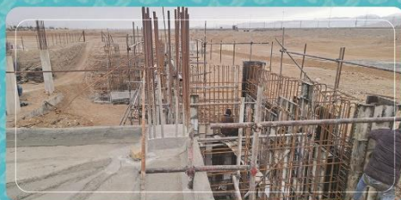
تکمیل آرماتوربندی و شروع قالب‌بندی دیوار حائل گودال باغچه شمالی زون غربی (محوطه موتورخانه)
