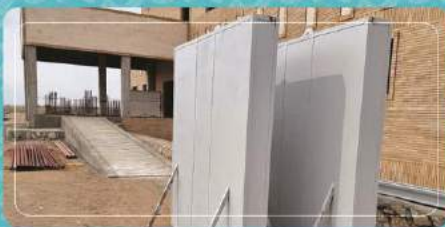
تکمیل ساخت و دریافت درهای سربی بونکرهای رادیوتراپی
