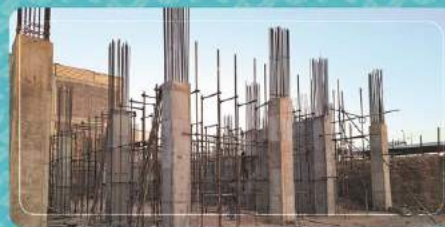
اجرای داربست‌های تیر اصلی و فرعی سقف اول زیرزمین زون مرکزی مرحله اول
