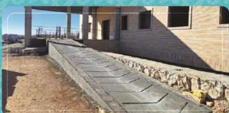
اجرای رمپ ورودی زون شرقی ضلع جنوبی
