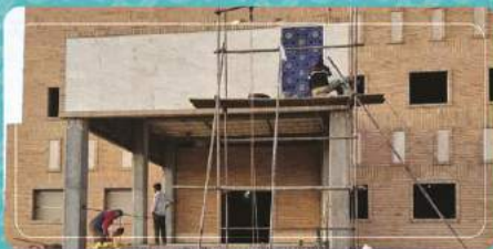
نصب کاشی المان یادبود نیکوکاران پروژه و تکمیل نمای سردر ورودی ضلع جنوبی زون شرقی
