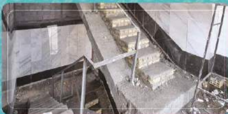
اجرای سنگ دیواره‌های پلکان
