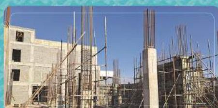
قالب‌بندی ستون‌های زون مرکزی و دیواربرشی ضلع جنوبی
