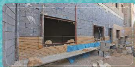
اجرای نمای شمالی زون شرقی
