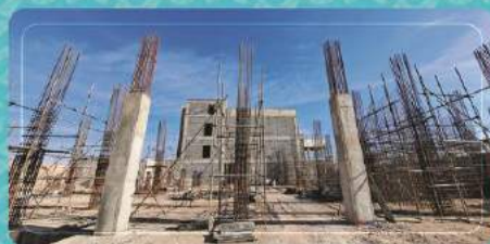
اجرای داربست و آرماتوربندی ستون‌های زون مرکزی
