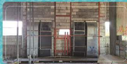
تکمیل اجرای کانال‌های هوارسان بونکرها
