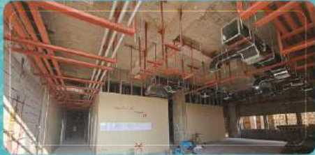
ادامه اجرای تأسیسات مکانیکی زون شرقی
