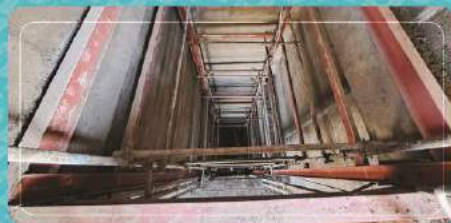
اجرای شامی‌کشی و سیمان‌کاری چاله آسانسور
