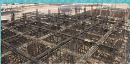
آرماتوربندی تیرهای اصلی سقف اول زون مرکزی (مرحله اول)
