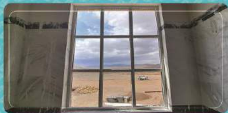
اجرای سنگ دیواره دستگاه پله، گچ‌کاری و نصب چارچوب پنجره‌های upvc
