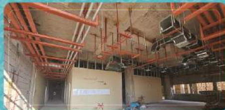
ادامه اجرای تأسیسات زیر سقف بخش رادیوترایی
