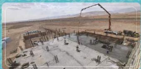
بتن‌ریزی سقف اول زون مرکزی، مرحله دوم
