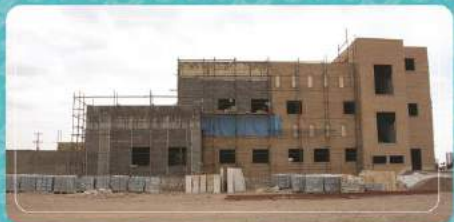
ادامه تکمیل نمای شمالی زون شرقی پروژه
