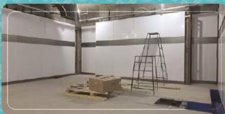
نصب ورق‌های ام‌دی‌اف، اجرای نازک‌کاری یونکر اول رادیوترایی
