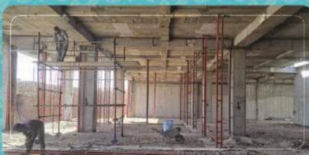
اجرای وال‌پست دیوارهای موتورخانه، زیرزمین زون مرکزی
