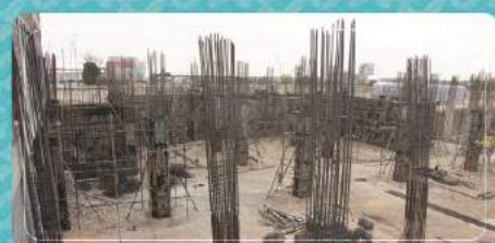
آرماتوربندی و قالب‌گیری ستون‌ها و دیوار حائل شمالی زیرزمین زون مرکزی
