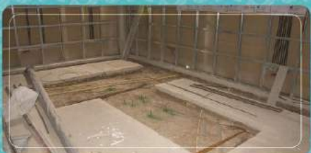
اجرای ترنج تأسیسات و فونداسیون دستگاه سی‌تی‌سی سیمولاتور
