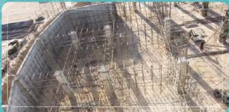
اجرای درپست تیرهای اصلی سقف اول زون مرکزی
