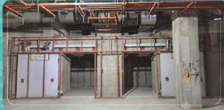
اجرای شاسی‌کشی در و تابلو برق درهای سربی رادیوترایی
