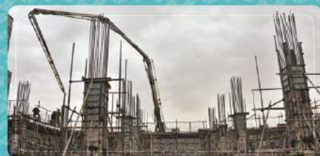
بتن‌ریزی ستون‌ها و دیوار حائل شمالی زیرزمین زون مرکزی
