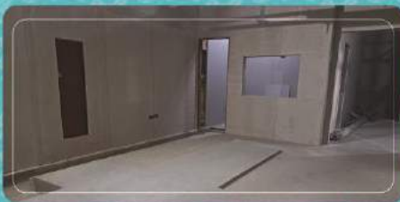
تکمیل نصب پنل‌های سربی دیواری اتاق سی‌تی سیمولاتور
