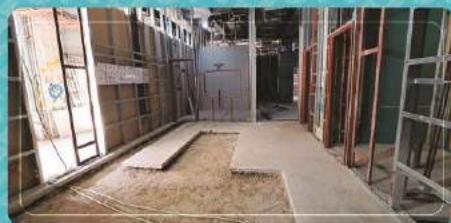
اجرای شامی‌کشی لیزرهای دستگاه سی‌تی سیمولاتور و ساخت و نصب فریم بازشوها
