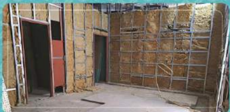
نصب پشم سنگ بین دیوارهای کناف
