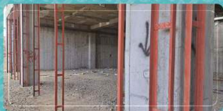
ساخت و نصب وال‌پست دیوارهای موتورخانه، زیرزمین زون مرکزی
