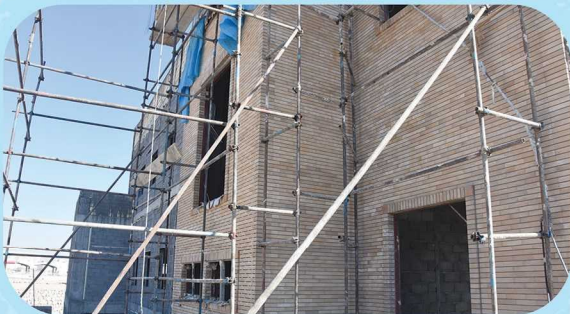
اجرای داربست نمای شمالی زون شرقی
