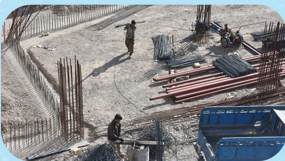
برش آرماتورهای ستون، دیواربرشی و خاموت زنی
