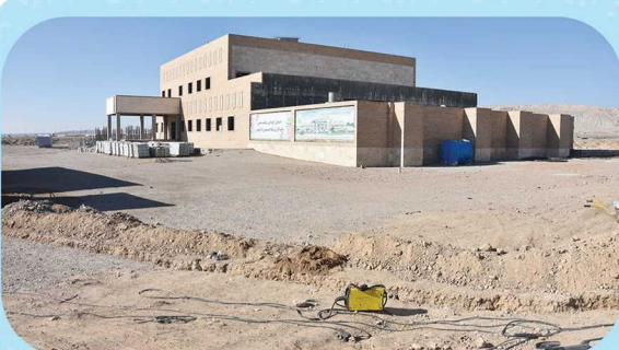
اجرای حفاری انشعاب گاز داخل کارگاه
