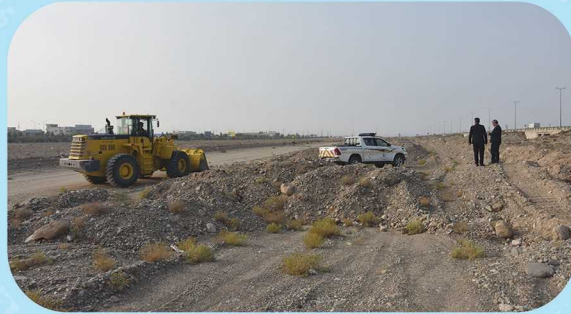
تقویت سیل بند ضلع شمالی سایت پروژه
