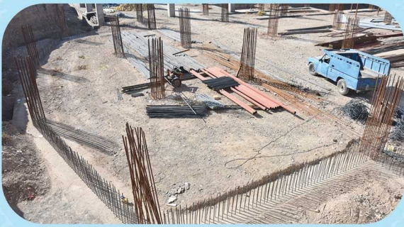
کاشت میلگرد برای اجرای دیواربرشی ضلع جنوبی طبقه زیرزمین زون مرکزی
