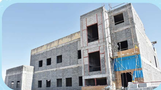
آغاز نمای شمالی زون شرقی
