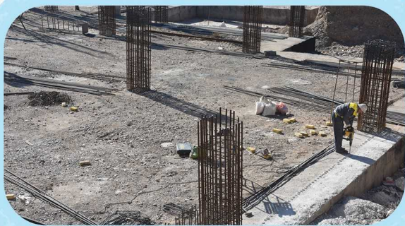
کاشت میلگرد آرماتورهای دیواربرشی ضلع شمالی زیرزمین زون مرکزی
