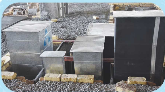
اجرای کانال‌های رفت و برگشت در داکت تأسیسات
