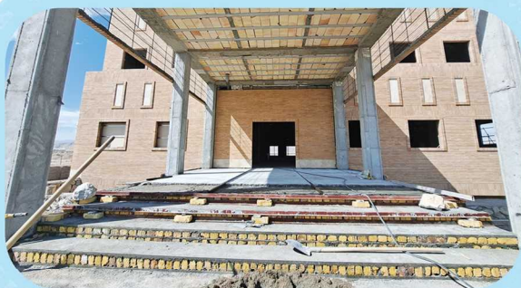
اجرای پله و شاسی‌کشی سردر ورودی ضلع جنوبی زون شرقی
