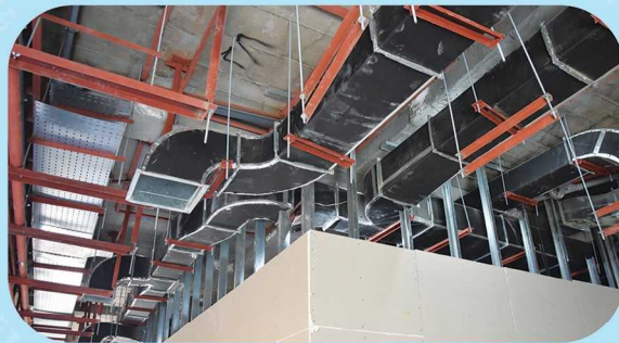
اجرای ساپورت، کانال کشی و نصب سینی های برق زیرسقف زیرزمین
