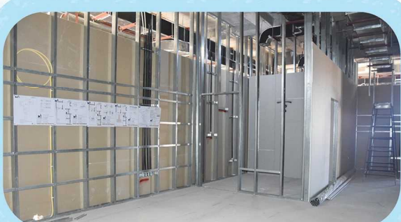
اجرای لوله و قوطی‌های برق داخل اتاق‌های زیرزمین زون شرقی
