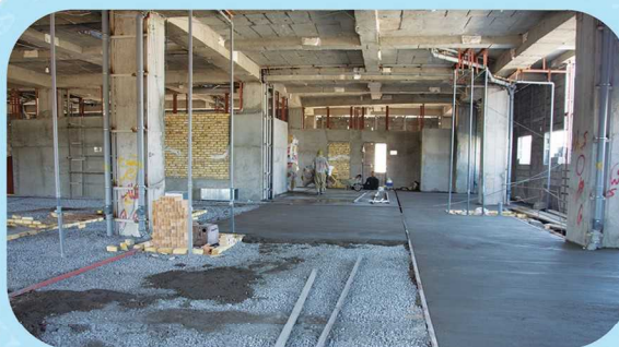
بتن‌ریزی طبقه همکف زون شرقی
