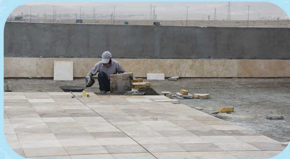
اجرای سنگ کف پشتبام زون شرقی
