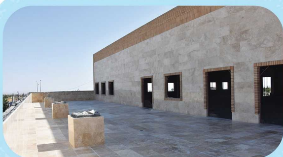
اتمام کف‌سازی بالکن طبقه اول زون شرقی
