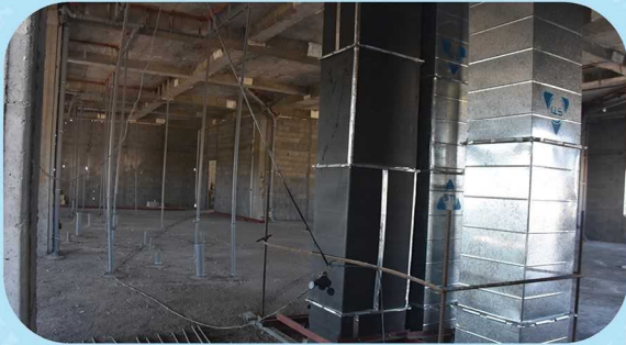
ادامه اجرای کانال های رفت و برگشت از طبقه همکف به پشتبام
