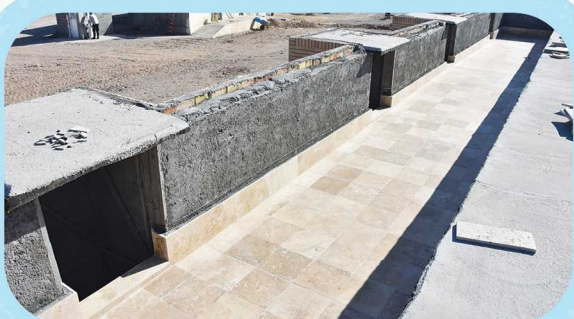
شروع اجرای سنگ کفبام بونکر
