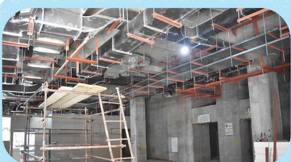
نصب کانال‌های رفت و برگشت و سینی‌های برق لابی انتظار رادیوتراپی
